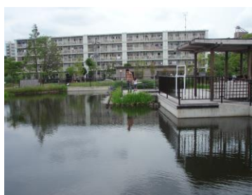
小学校跡地を利用した ビオトープ公園完成
