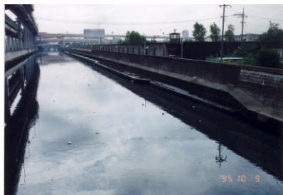
コンクリート護岸の続く綾瀬川下流
